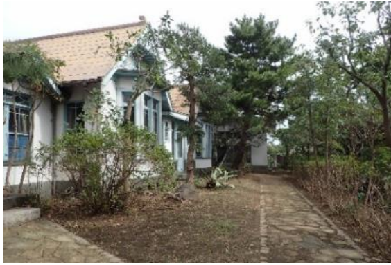
写真 4 洋室棟南側外観 (2018 年 10 月撮影)
