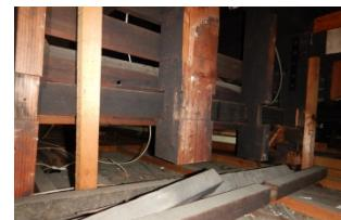
写真 48 間仕切り改造による柱切断（2019 年撮影）
