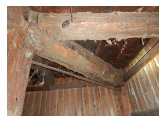
写真66 緊結鉄筋棒（2019年撮影）
