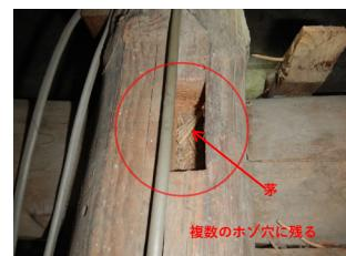
写真64 ほぞ穴内部に残る茅材破片（2019年撮影）
