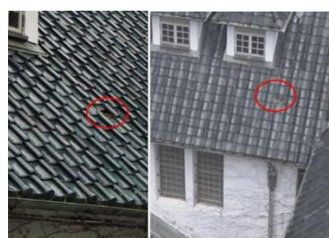
写真 59 一部落下した屋根瓦
