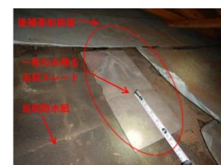
写真 52 北側屋根に残るスレート材（2019 年撮影）
