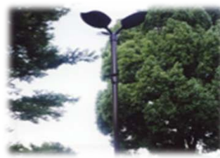
ソーラー照明 蓄電により夜間の園内避難が可能
