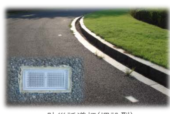
防災誘導灯(埋設型) 蓄電により夜間の園路誘導可能(LED)
