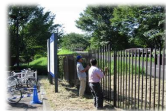
脱着フェンス フェンスを外すことで園内へ避難可能
