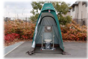
仮設トイレ 地下に汚物槽を埋め、地表部に排泄用の穴を設けた汲取式トイレ
