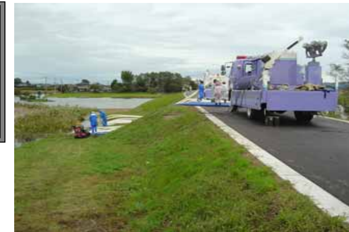
被害軽減対策 (排水ポンプ車稼働状況)
