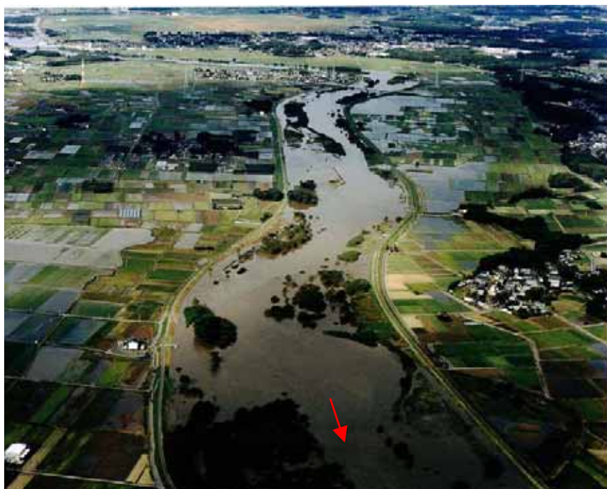
洪水時の状況（平成16年10月 愛国橋 41km 付近）
