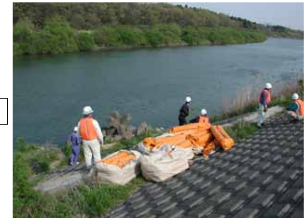
水質事故の状況 (オイルフェンスの設置)
