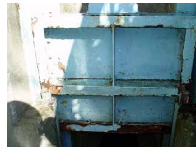
老朽化したゲートの状況
