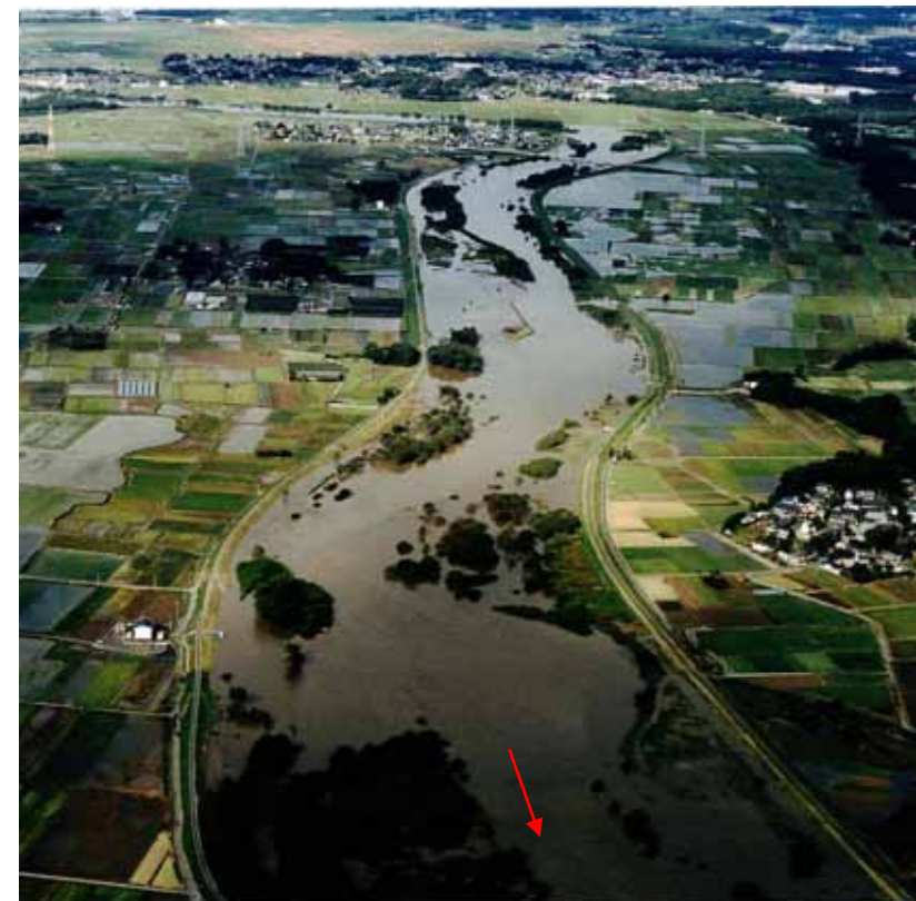
平成16年10月洪水41km付近 (愛国橋上流)
