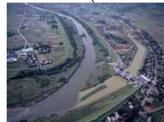
伊丹排水機場
