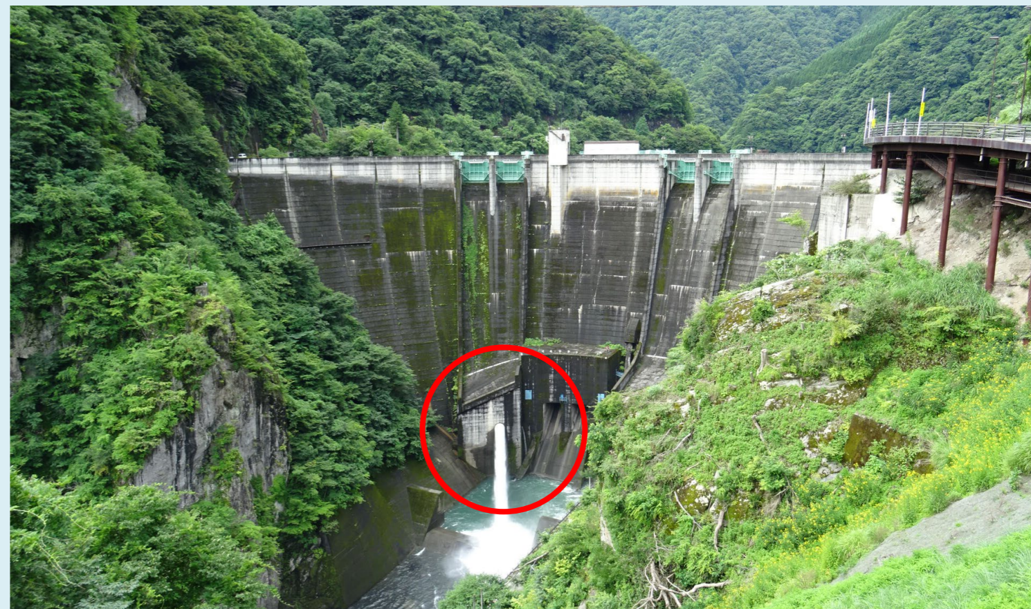
ダム名：二瀬ダム 放流ゲート：利水放流設備 (ハウエル放流管) + 常用洪水吐(降雨による流入量増時)
