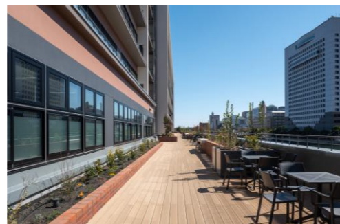
津波避難スペース「しんこうデッキ」
