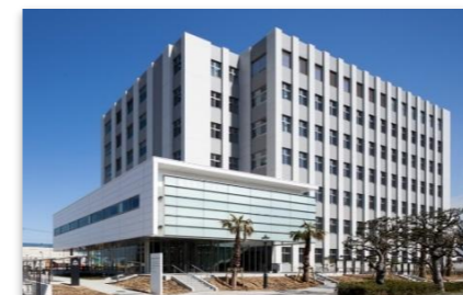
横須賀地方合同庁舎
