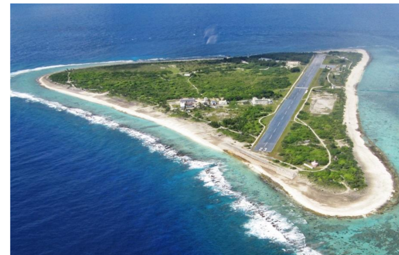
南鳥島において気象庁の施設を整備
