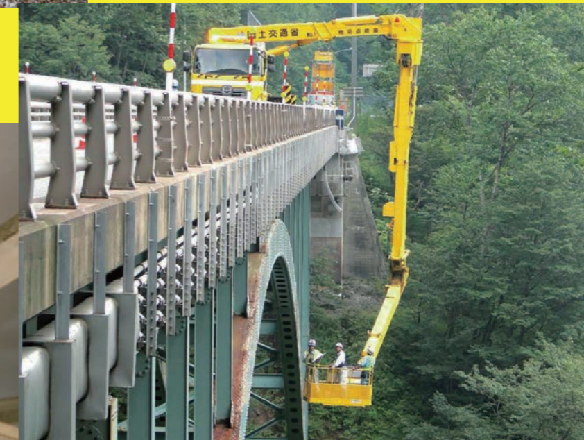
建設機械を使用して安全に効率よく点検
