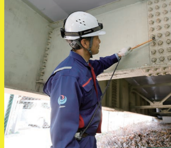
打音点検など人の手と経験で培われたカンが道路などの構造物の耐久性を支える
