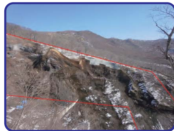
②般若沢山腹工
