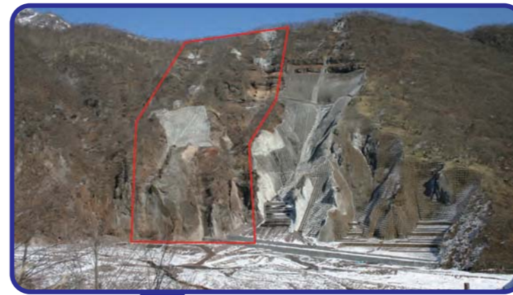
⑤稲荷川山腹工
