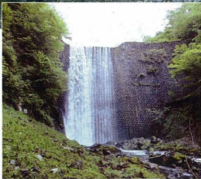
方等上流砂防堰堤
