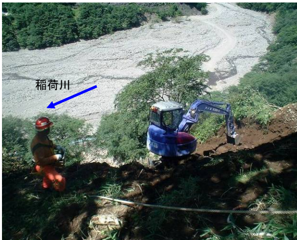
ロッククライミングマシンによる無人化施工
