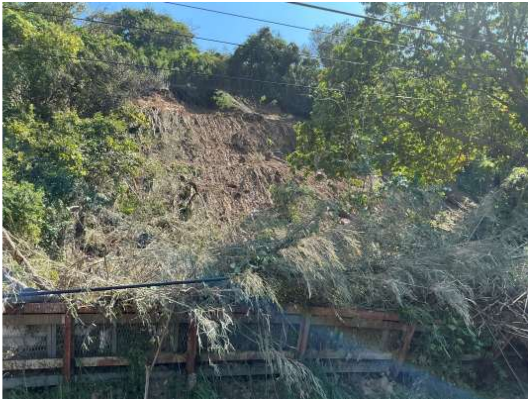
線路内より撮影 着工前
