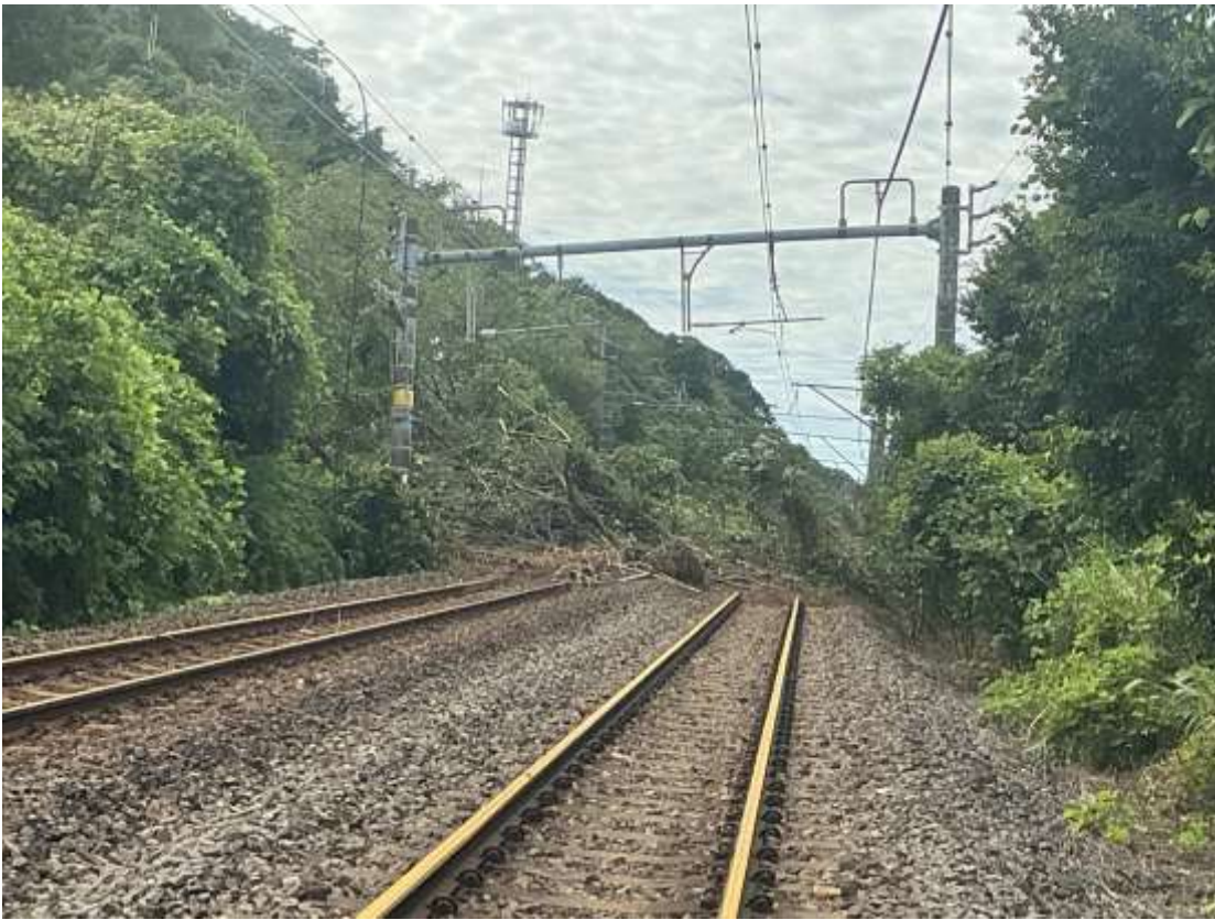
起点方（姉ヶ崎）より撮影 着工前
