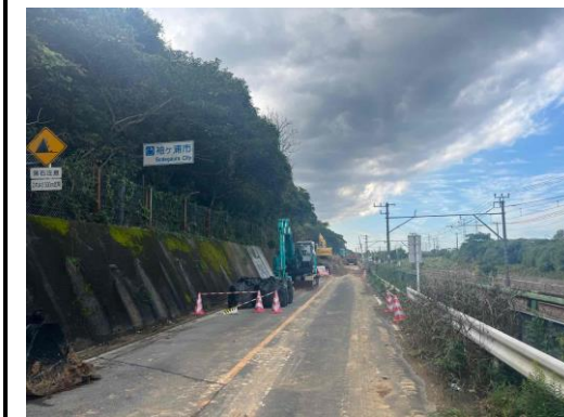
擁壁背面及び路面の土砂撤去中（県）
