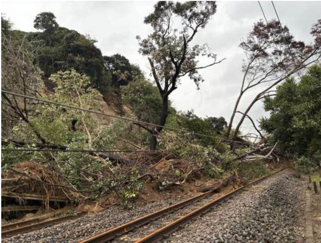
線路内より撮影 着工前
