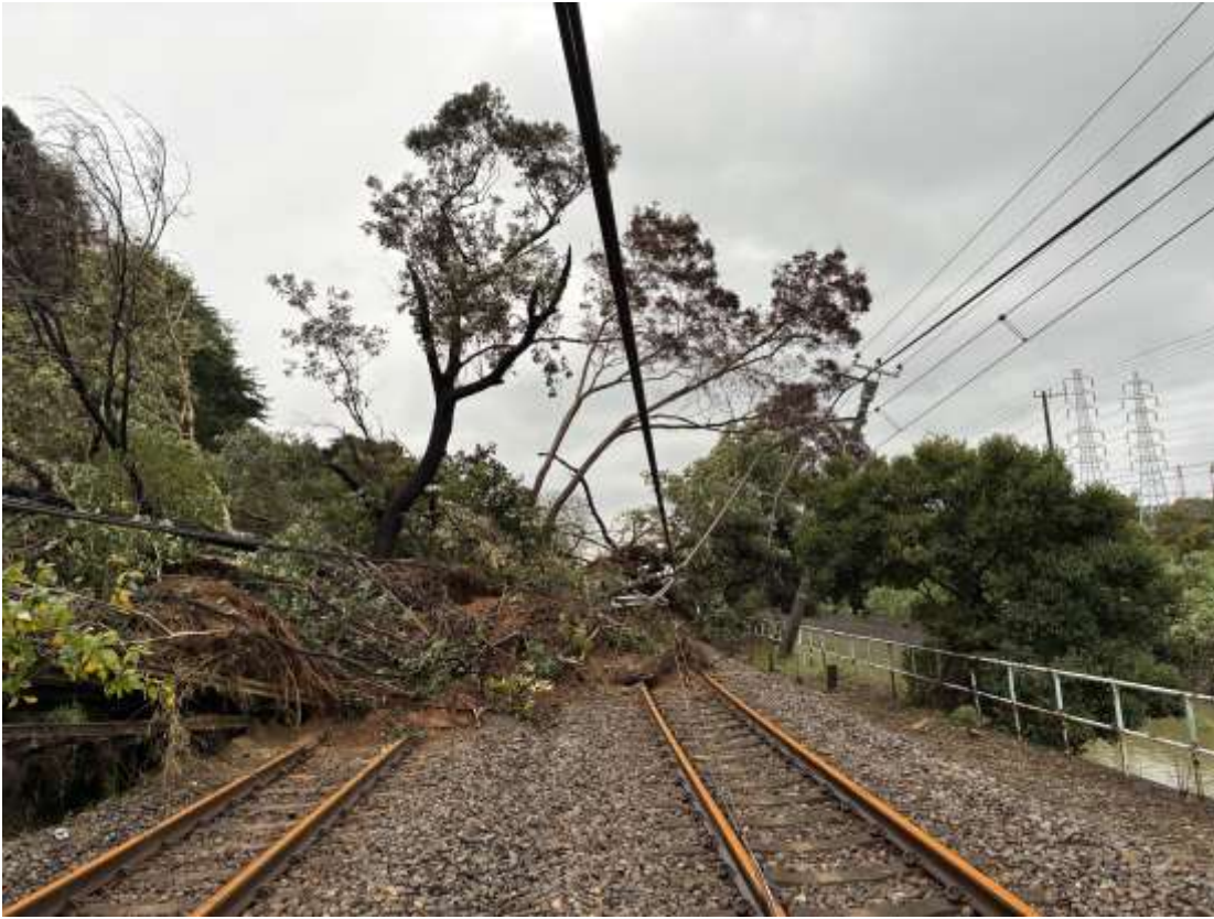
起点方（姉ヶ崎）より撮影 着工前
