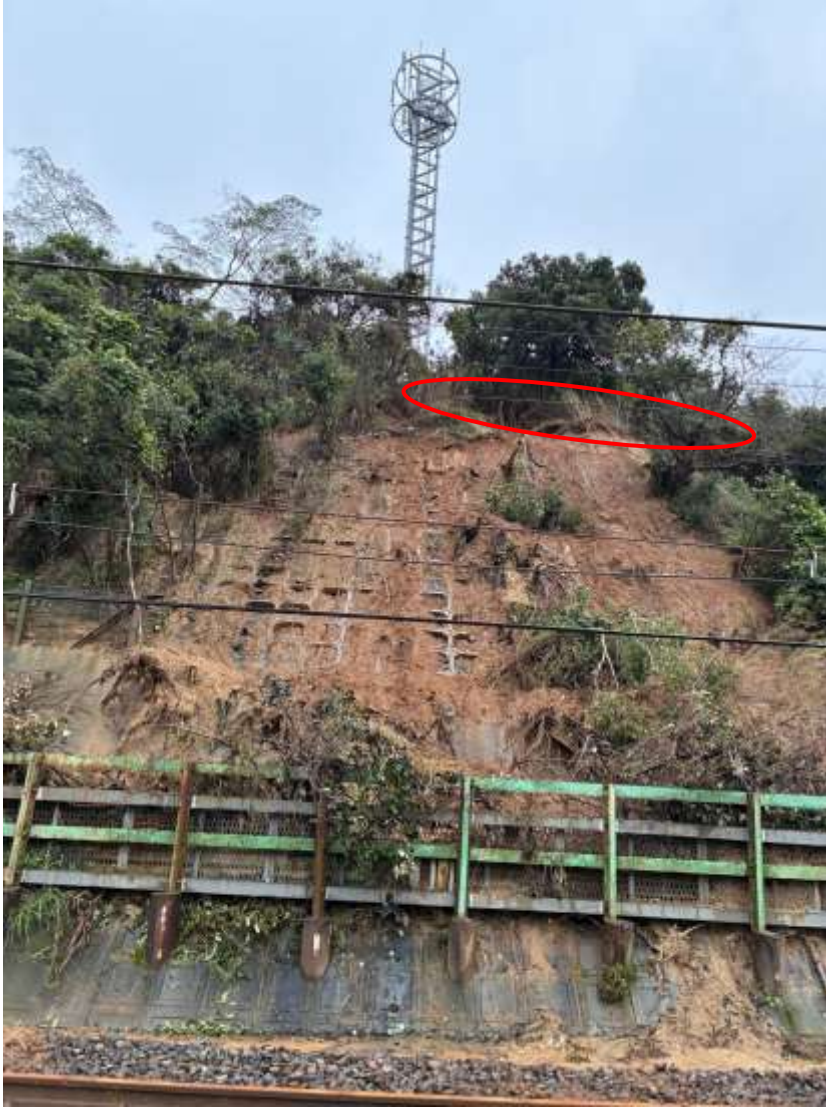
線路内より撮影 着工前
