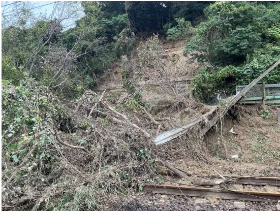
線路内より撮影 着工前
