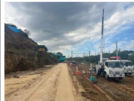
擁壁背面及び路面の土砂撤去中（県）
