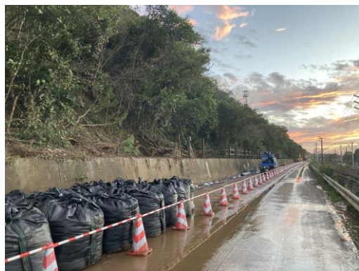
軌道及び路面の土砂撤去（JR）
