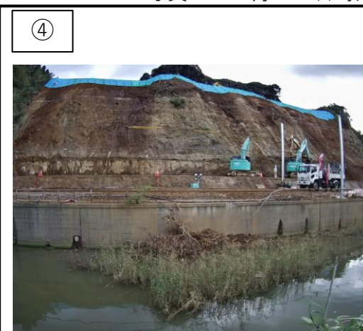
擁壁背面及び路面の土砂撤去中（県）
