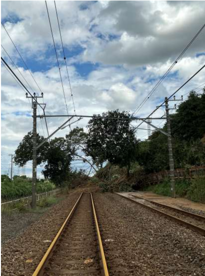
終点方（長浦）より撮影 着工前
