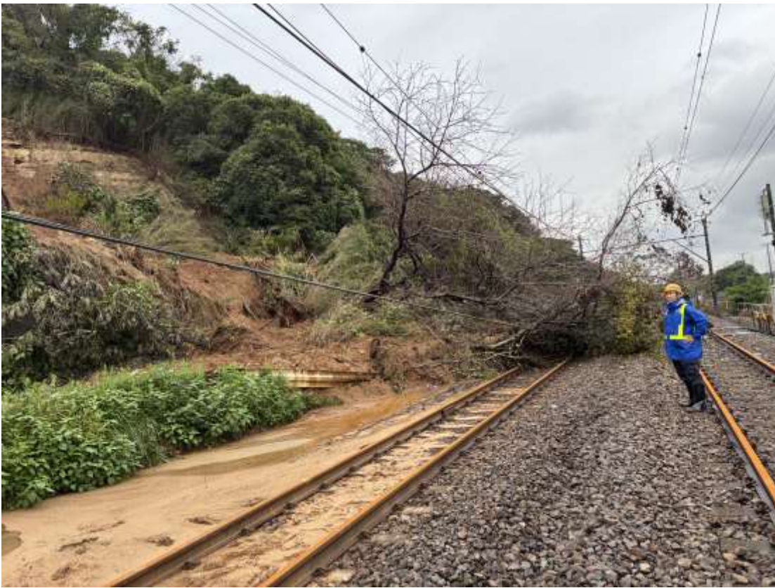
起点方（姉ヶ崎）より撮影 着工前
