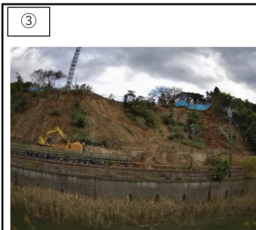
擁壁背面及び路面の土砂撤去中（県）
