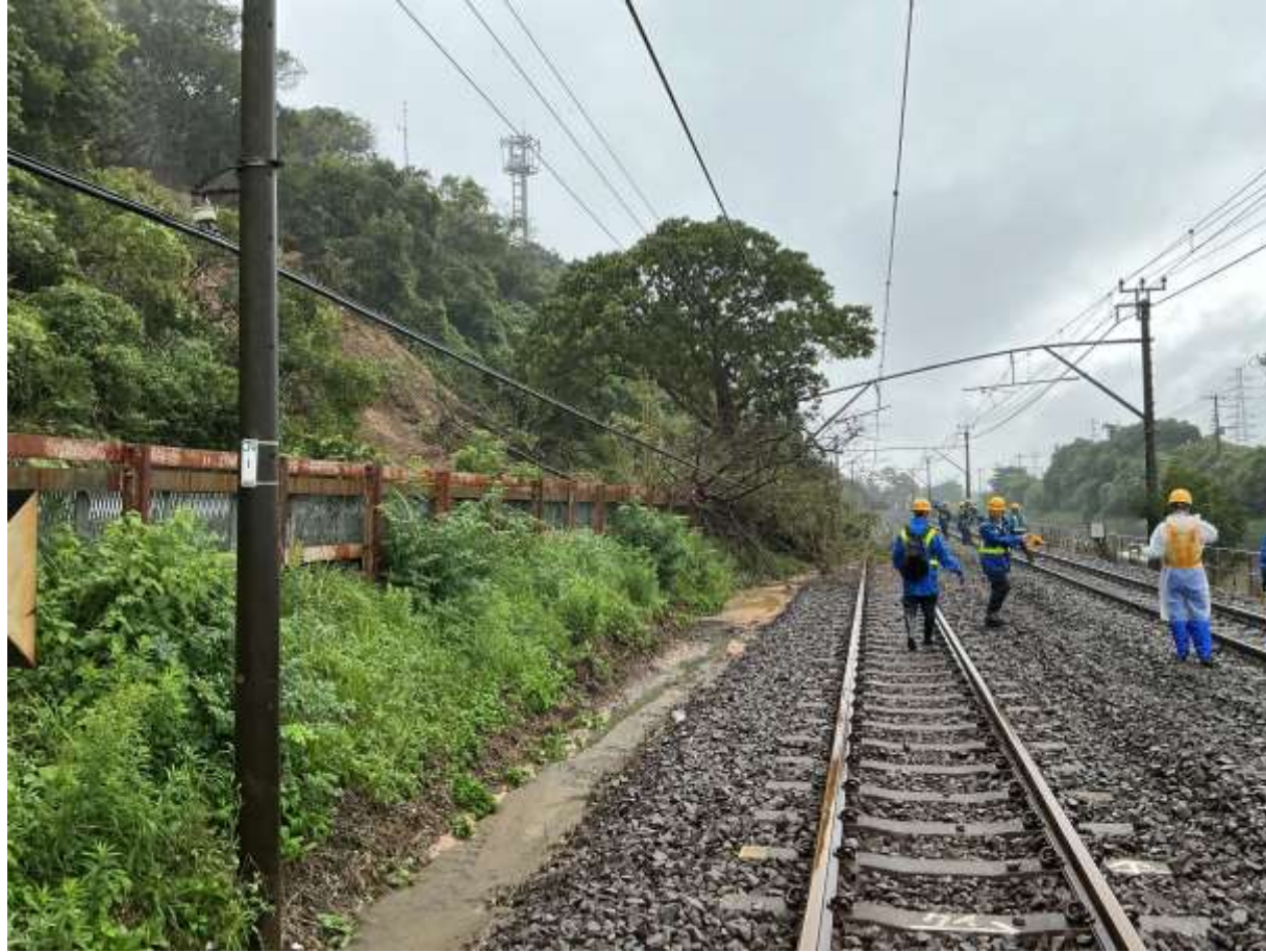
起点方（姉ヶ崎）より撮影 着工前
