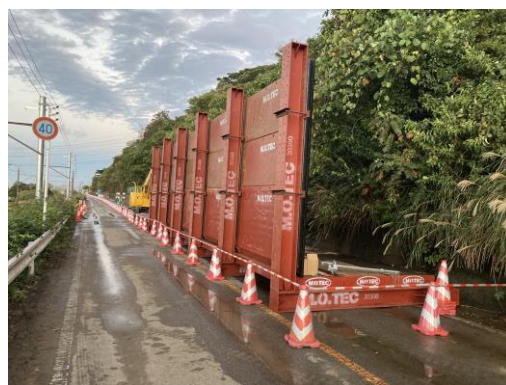
仮設防護柵設置中（県）
