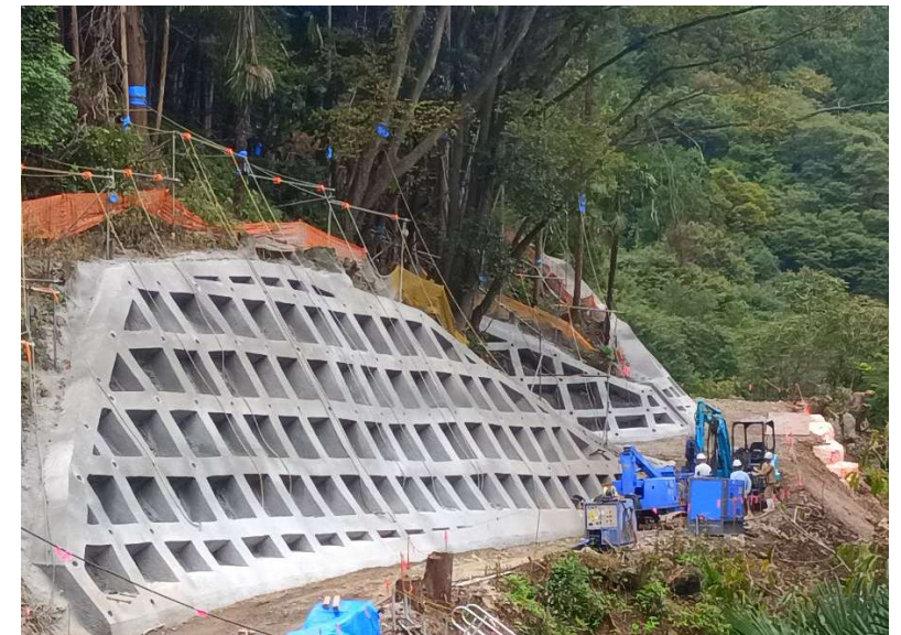
法面工 鉄筋挿入等
