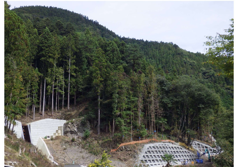
法面工 鉄筋挿入等
