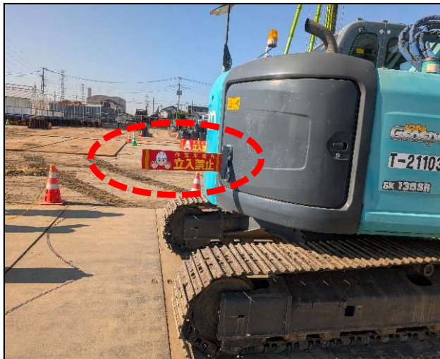
接触防止バーを設置
