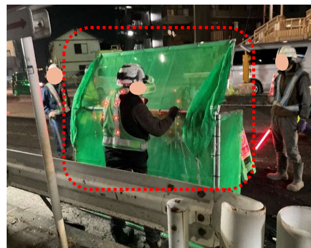
はつり殻が飛散しないよう、ネットフェンスにて養生
