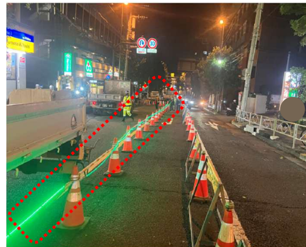
作業エリアと歩行者通路との境にLEDチューブライトを設置し、歩行者が認識しやすい表示とした
