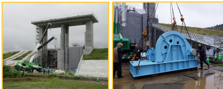
排水門（下流から）
