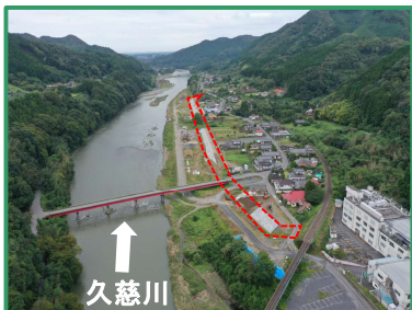
工事箇所の全景（上流から）
