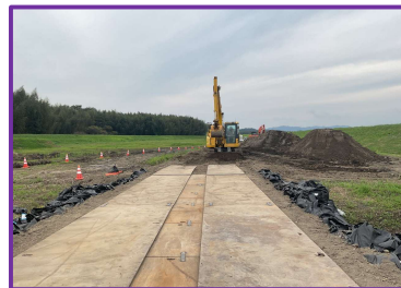
工事用道路の整備を行っています
