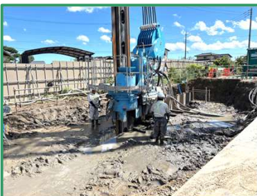
鋼矢板の圧入作業を行っています
