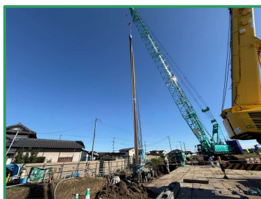
鋼矢板の圧入作業を行っています
