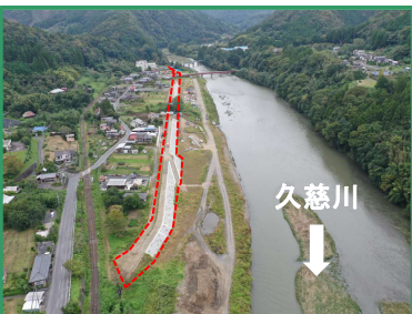
工事箇所の全景（下流から）
