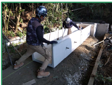
U字溝の設置作業を行っています
