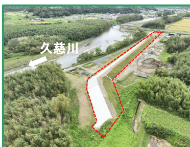
工事箇所の全景（下流から）
