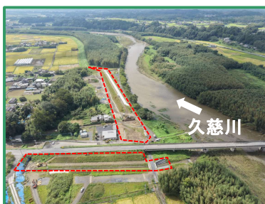
工事箇所の全景（上流から）
