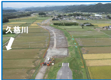
工事箇所の全景（下流から）
