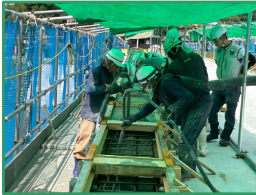
コンクリートを打設しています。
