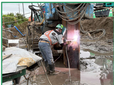
鋼矢板の溶接作業を行っています
