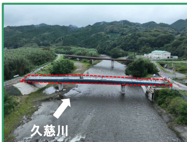
工事箇所の全景（上流から）
