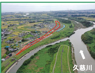
工事箇所の全景（上流から）
