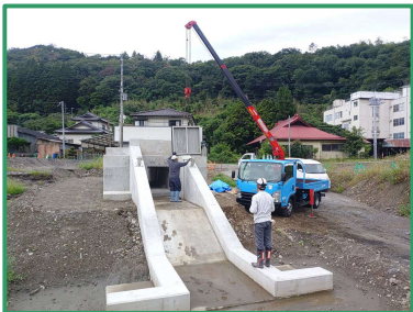
樋管の整備を行っています
