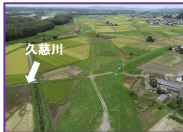
工事箇所の全景（下流から）
