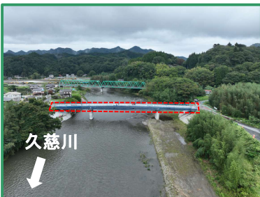
工事箇所の全景（下流から）
