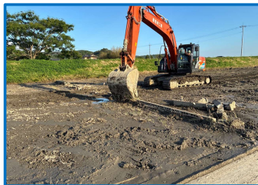
工事用道路の整備を行っています
