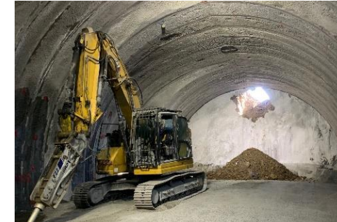
【新小仏トンネル(仮称) 東坑口】 貫通した東坑口
