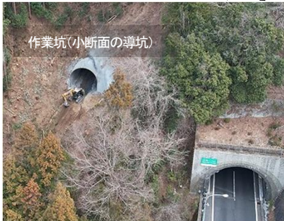
【新小仏トンネル(仮称) 西坑口】 作業坑(小断面の導坑) 作業坑の施工による西坑口(外側斜面)の先行整備
