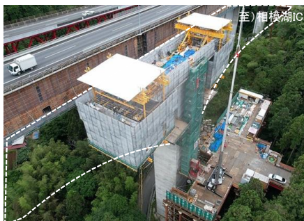
【新底沢大橋(仮称)】 橋梁下部工は4/6基着手。内2基が完成済。 一部の橋脚で張り出し部の施工に着手。
