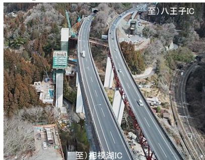
【新底沢大橋(仮称)】 橋梁下部工は4/6基着手。内2基が完成済。 一部の橋脚で張り出し部の施工に着手。
