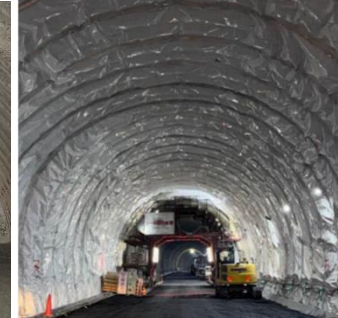
防水シート及び覆工コンクリートを施工中
