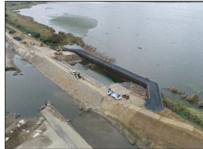
二重締切工完了
