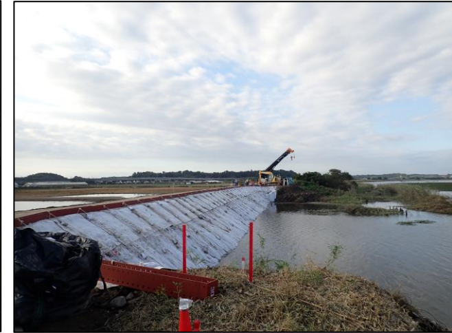
荒締切工完了
