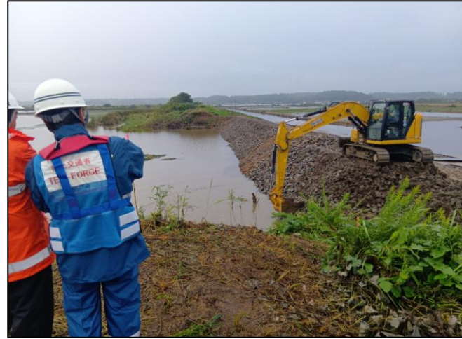
荒締切工施工中
