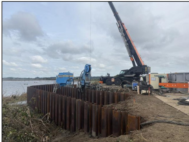
二重締切工(鋼矢板打込み)施工中
