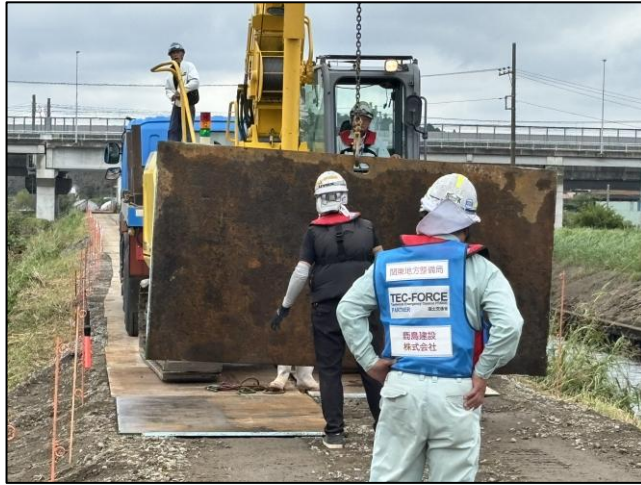
工事用道路施工中
