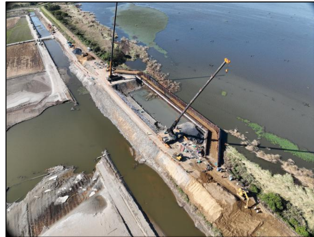
二重締切工(中詰め)施工中
