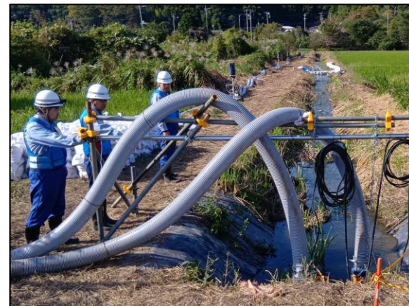
酒々井町の排水支援状況
