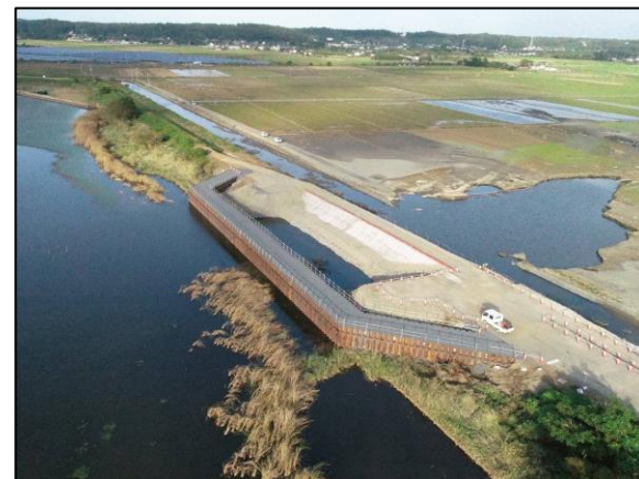
印旛沼の応急復旧作業状況(千葉県成田市)
