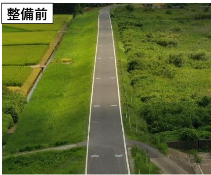
西浦(潮来市永山地先)の整備事例
