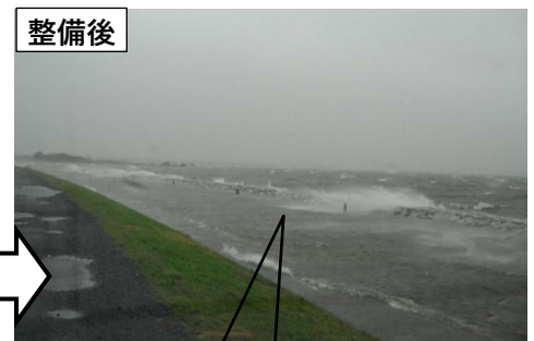
離岸堤による消波効果の事例
