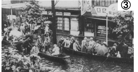
浸水状況【土浦市内】
