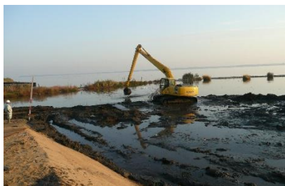
沈殿ピットの堆積土砂撤去の状況
