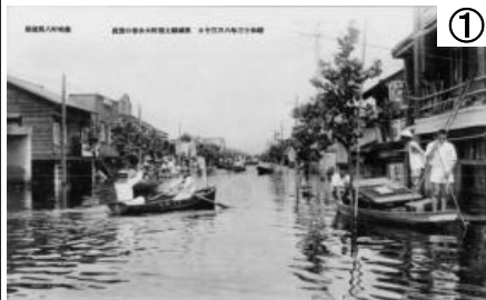
浸水状況【土浦市内】
