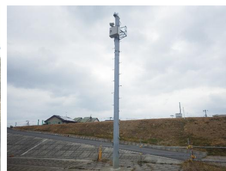
常陸川水門左岸下流 CCTV設置
