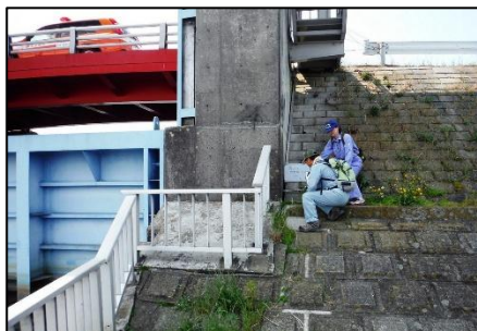
河川巡視状況
