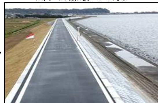
法面・天端被覆による対策
