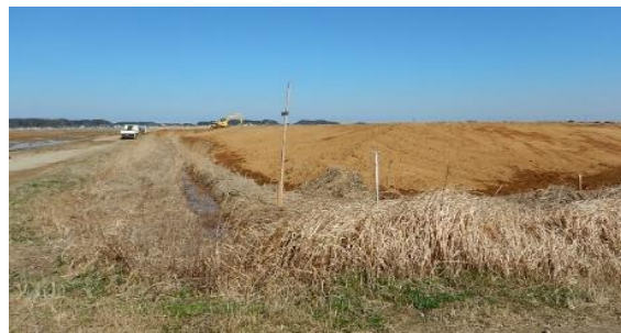
建設発生土受入状況
