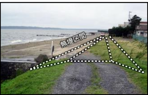
無堤部の状況 (北浦右岸釜谷地区)
