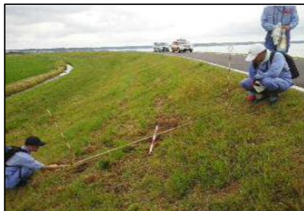
堤防点検状況
