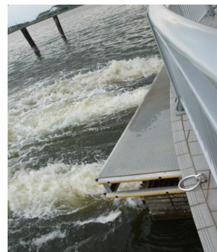
排水管吐出部からの排水状況
