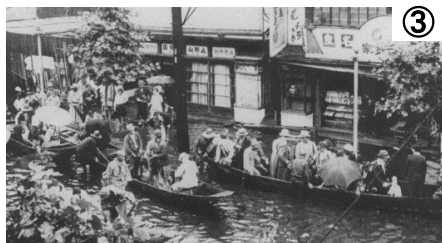
浸水状況【土浦市内】
