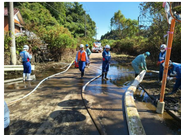
酒々井町の排水支援状況
