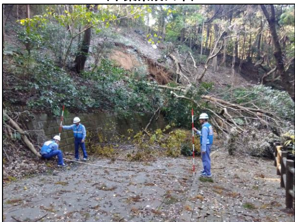
被災状況調査(千葉県東金市)
