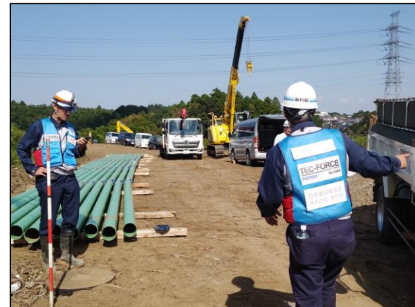
酒々井町の排水支援状況
