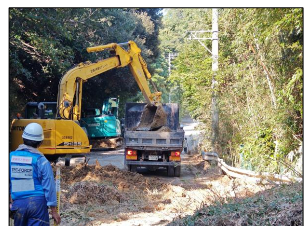
道路啓開活動状況(千葉県長柄町)
