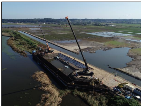
印旛沼の応急復旧活動状況 (千葉県成田市)
