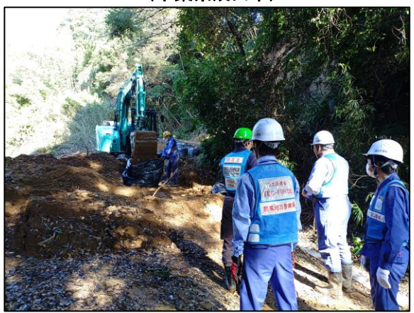
道路啓開活動状況(千葉県大網白里市)
