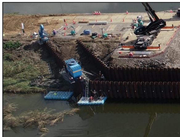
印旛沼の応急復旧活動状況 (千葉県成田市)
