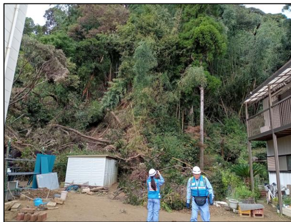
被災状況調査(千葉県茂原市)
