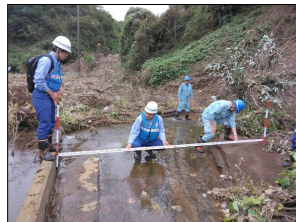
被災状況調査(神奈川県三浦市)
