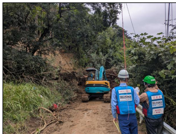
道路啓開活動状況(千葉県市原市)
