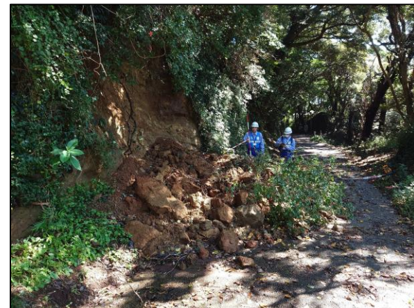
被災状況調査(神奈川県三浦市)
