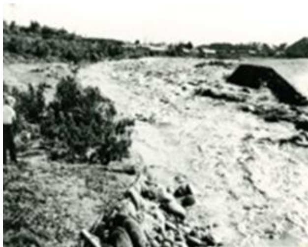
写真 1 昭和 34 年（1959 年）笛吹川左岸決壊（山梨県山梨市）
