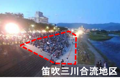
階段護岸・親水護岸の整備
