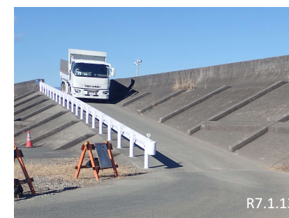
水辺整備事業箇所 (五貫島地区)
