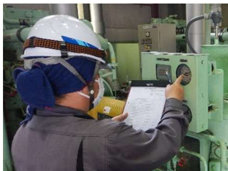
樋門・樋管点検 (巻き上げ機点検状況)
