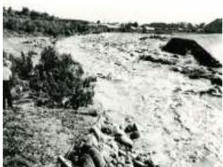
笛吹川左岸の堤防の決壊
