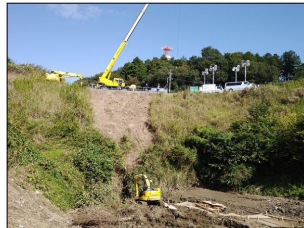
酒々井町の排水支援状況
