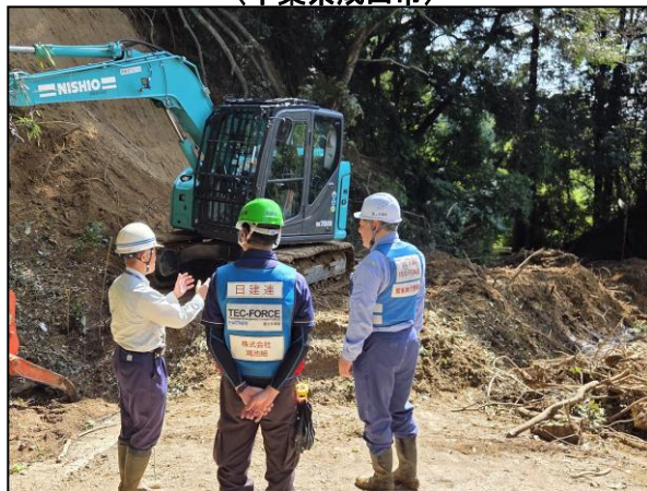
道路啓開活動状況(千葉県大網白里市)
