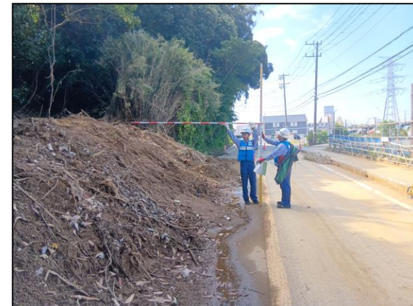
被災状況調査(千葉県袖ヶ浦市)
