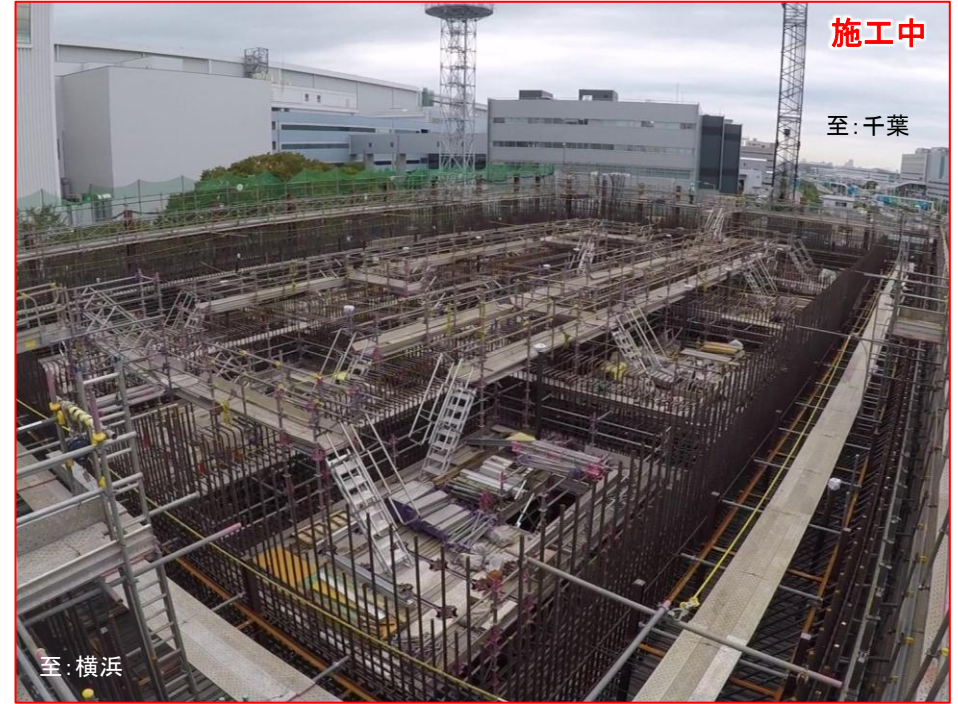
📷 ②: 羽田立坑外景(ニューマチックケーソン工法による立坑構築)
