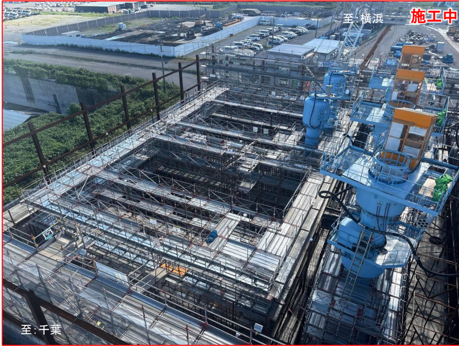
📷 ①: 浮島立坑外景(ニューマチックケーソン工法による立坑構築)
