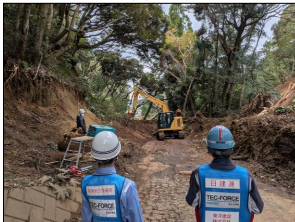
道路啓開活動状況(千葉県東金市)
