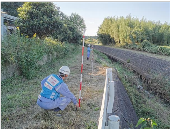
被災状況調査(千葉県印西市)
