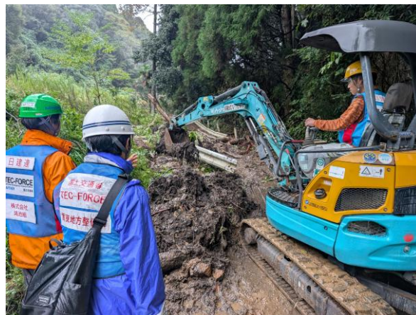
道路啓開活動状況(千葉県市原市)
