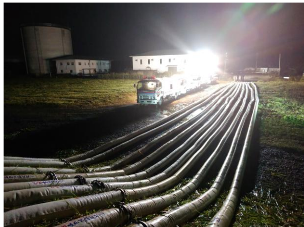
印旛沼の排水活動状況(千葉県成田市)
