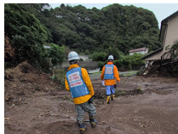
被災状況調査(神奈川県三浦市)
