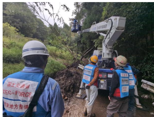
道路啓開活動状況(千葉県市原市)
