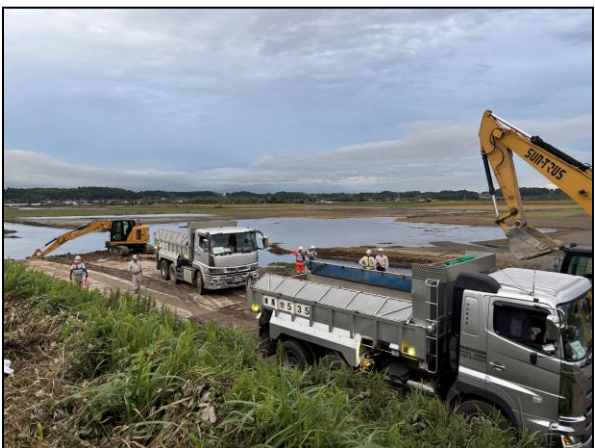
印旛沼の応急復旧作業状況 (決壊口へ堤防を支える石を投入)
