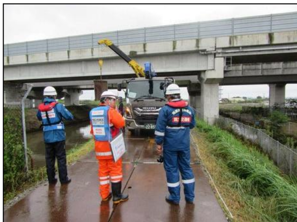
印旛沼の応急復旧作業状況(工事用道路)
