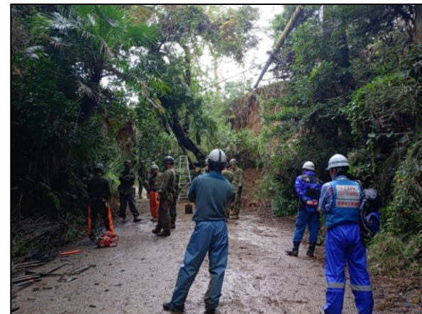
道路啓開活動状況(神奈川県三浦市)
