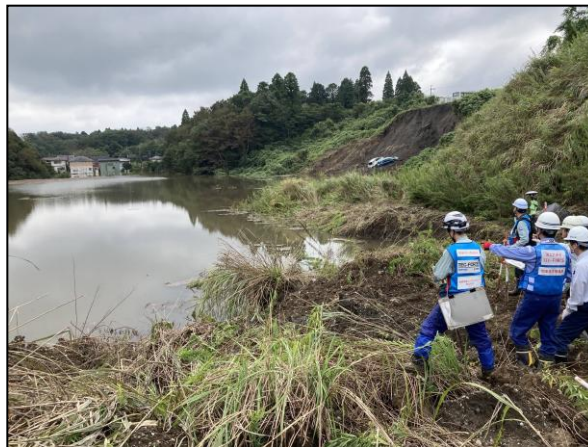
被災状況調査(酒々井町)
