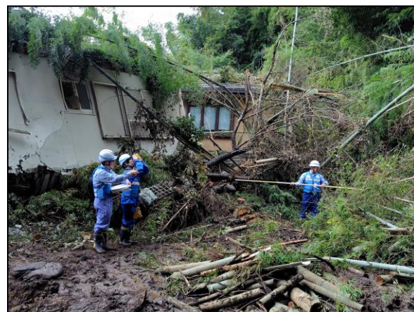
被災状況調査(神奈川県三浦市)
