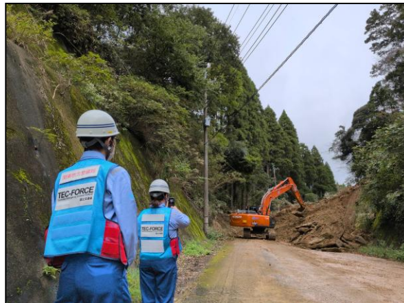
道路啓開活動状況(千葉県市原市)
