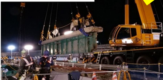
⑤既設の鋼桁の撤去状況
