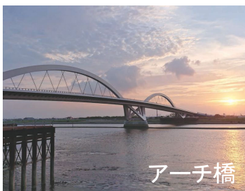
有明筑後川大橋(九州)
