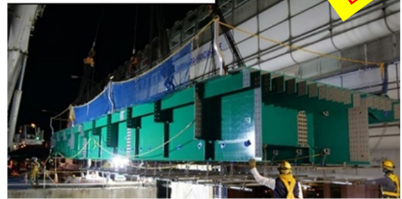
⑥新設の鋼桁の架設状況
