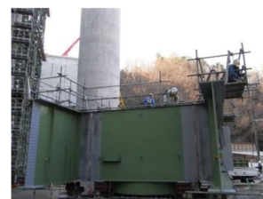
親綱設置による作業事例
