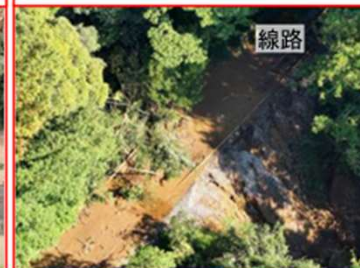
② 久留里線・上総松丘～上総亀山間 盛土崩壊
