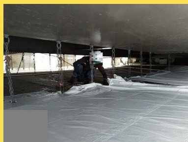
橋梁補修工 (塗装塗替足場工)
