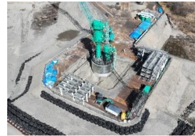
ニューマチックケーソン工
