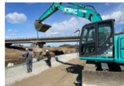
笠コンクリートブロック据付工
