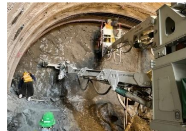
トンネル工（NATM）〔発破工法〕
