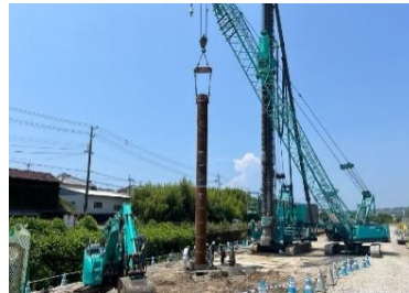
鋼管ソイルセメント杭工
