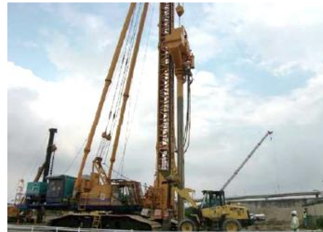
軟弱地盤処理工
