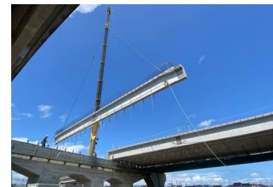
P C橋架設工
