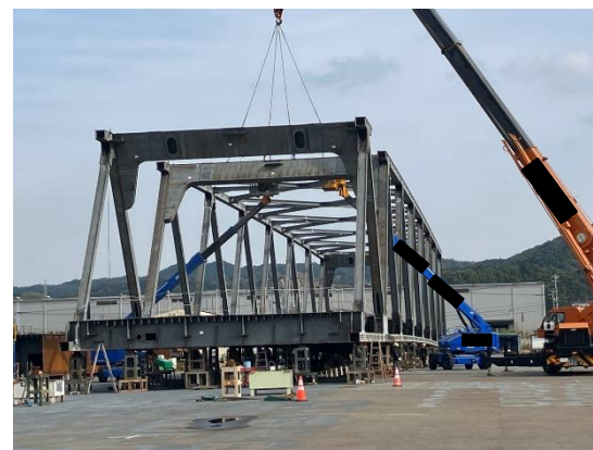
トラス仮組立状況
