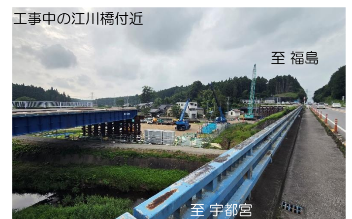
写真② 工事中の江川橋周辺の様子
