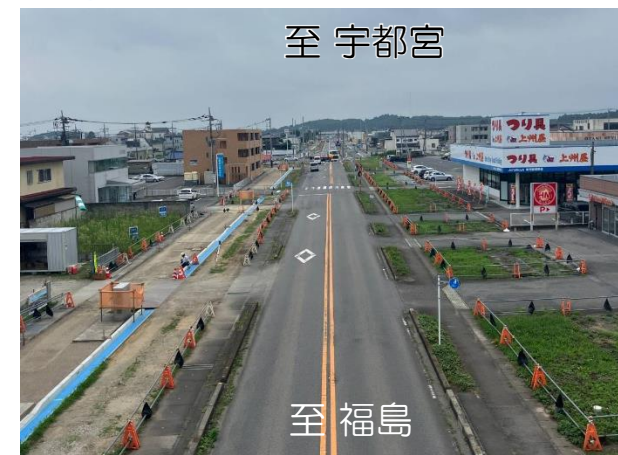
③ 市道拡幅区間の施工状況
