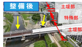
堤防整備の例 令和7年4月完成 ▲左岸 世田谷区玉川地先
