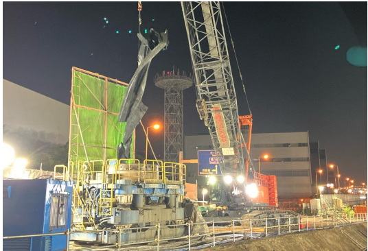
支障物(鋼矢板)
