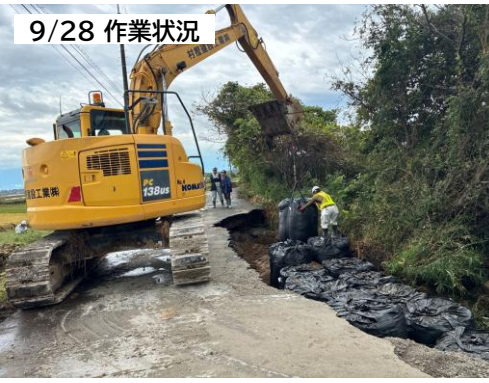
工事用道路整備(大型土のう設置)状況
