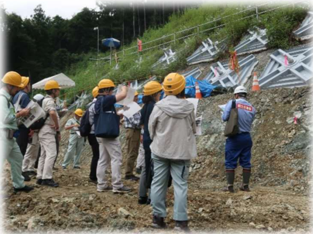
工事箇所説明 (アンカー工事)
