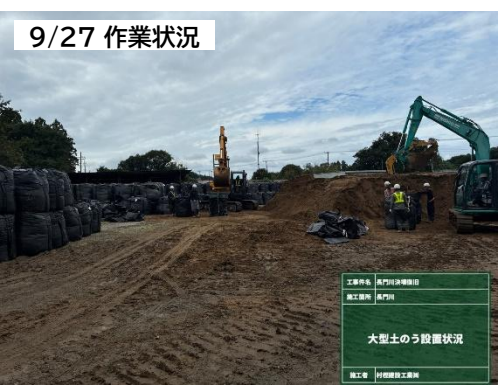
工事用道路整備(大型土のう作成)状況
