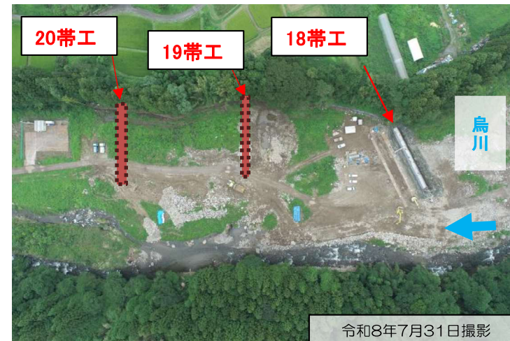
現場を上空から 第18帯工施工中
