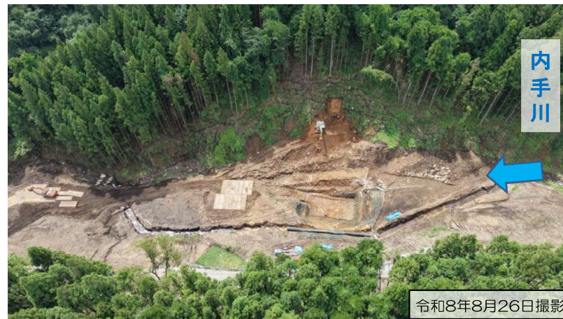
左岸側より 掘削作業中（空撮）
