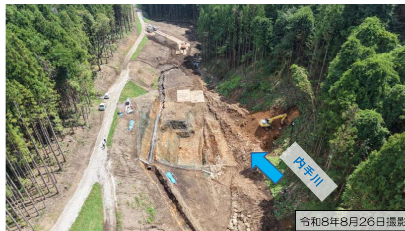
上流より 掘削作業中（空撮）
