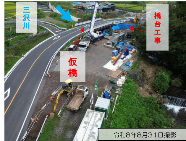
三沢橋を上空から
