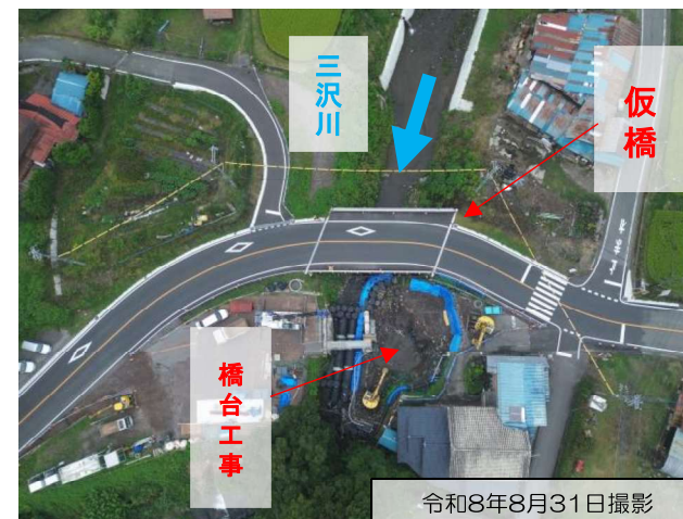
橋台工 施工状況
