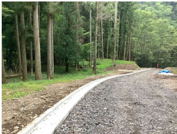
③ 撮影日：R8. 8. 31 ◆ No.38付近 排水構造物工 施工完了
