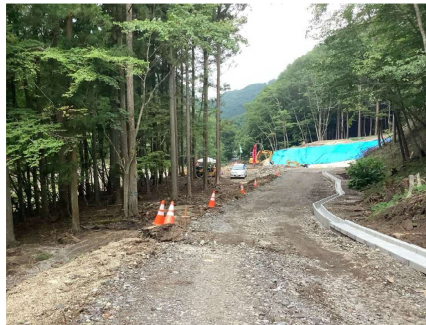
④ 撮影日：R8. 8. 31 ◆ No.43付近 排水構造物工 施工完了
