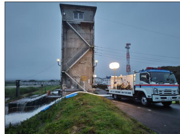
排水活動状況(栄町)
