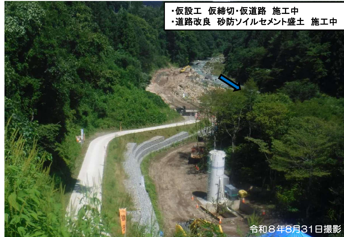
工事用道路(全景)
