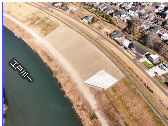
R6江戸川左岸三輪野山地先堤防整備工事 【流山市内の堤防整備工事】
