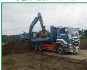
土砂の積み込み作業を行っています
