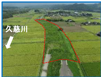
工事箇所の全景（下流から）
