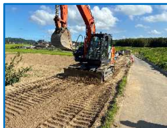
仮設坂路の拡幅を行っています
