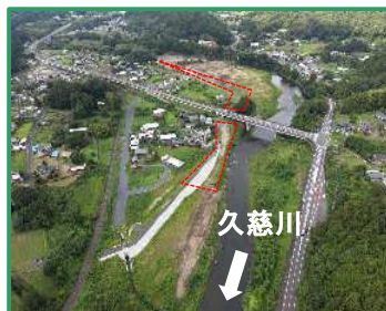
工事箇所の全景（下流から）
