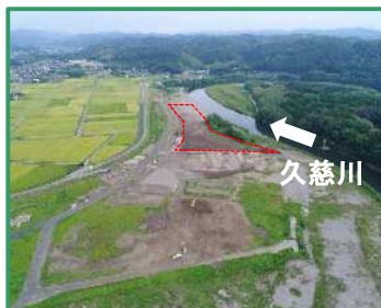
工事箇所の全景（上流から）
