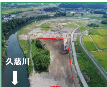
工事箇所の全景（下流から）
