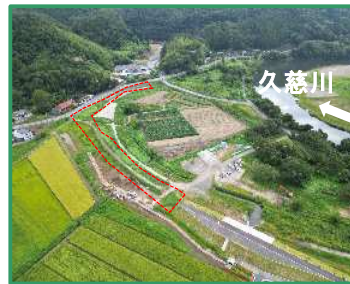
工事箇所の下流全景（上流から）
