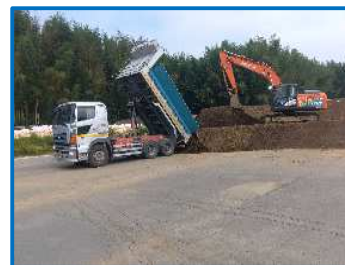
築堤土の受け入れを行っています
