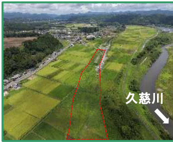
工事箇所の全景（下流から）
