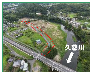
工事箇所の全景（上流から）
