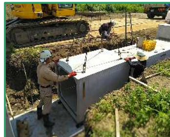
ボックスカルバートを設置しています
