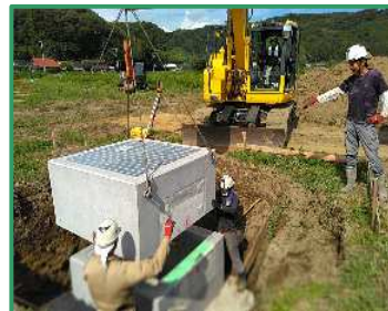
集水枡を設置しています
