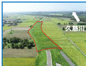
工事箇所の全景（上流から）
