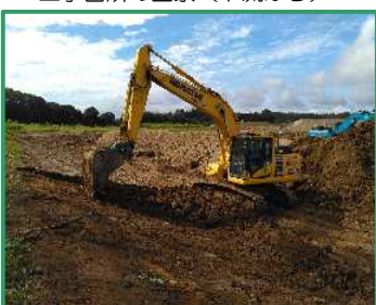
土砂の掘削作業を行っています
