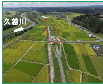
工事箇所の全景（上流から）
