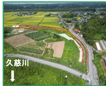
工事箇所の上流全景（下流から）
